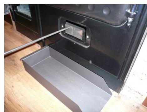
Figura nº16 - Accesos para la limpieza de la salida de humos.
